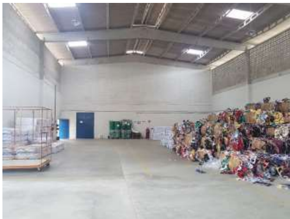
Vista interna galpão
