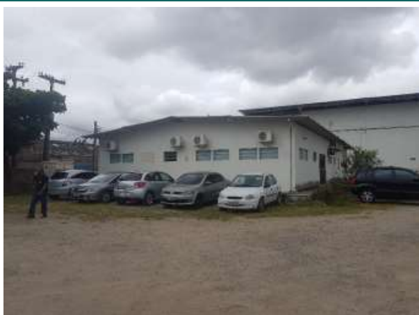
Vista bloco administrativo
